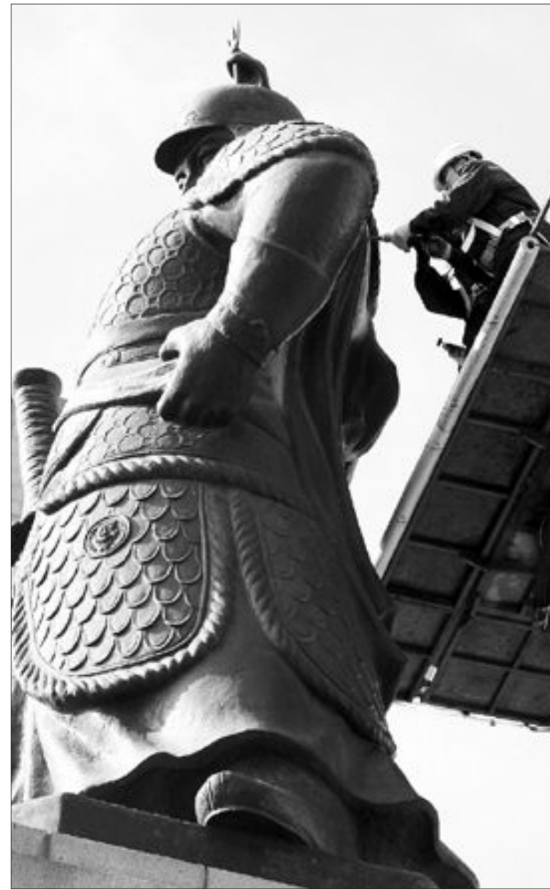
이순신 동상 ‘안전진단’ 서울 광화문광장의 이순신 장군 동상이 구조적으로 위험한 상태인 것으로 확인됐다. 서울시는 2일 이순신 장군 동상의 보전 관리를 위해 내시경과 초음파 비파괴검사 장비 등을 동원해 내부 상태를 점검한 결과, 동상 내부에 균열이 가고 부식이 진행되고 있는 것으로 나타났다. 사진은 서울시의 의뢰를 받은 시설물 안전 진단업체 직원들이 이순신 장군상에 대한 내시경 검사를 위해 뒤쪽 어깨부위에 구멍을 뚫는 모습.
