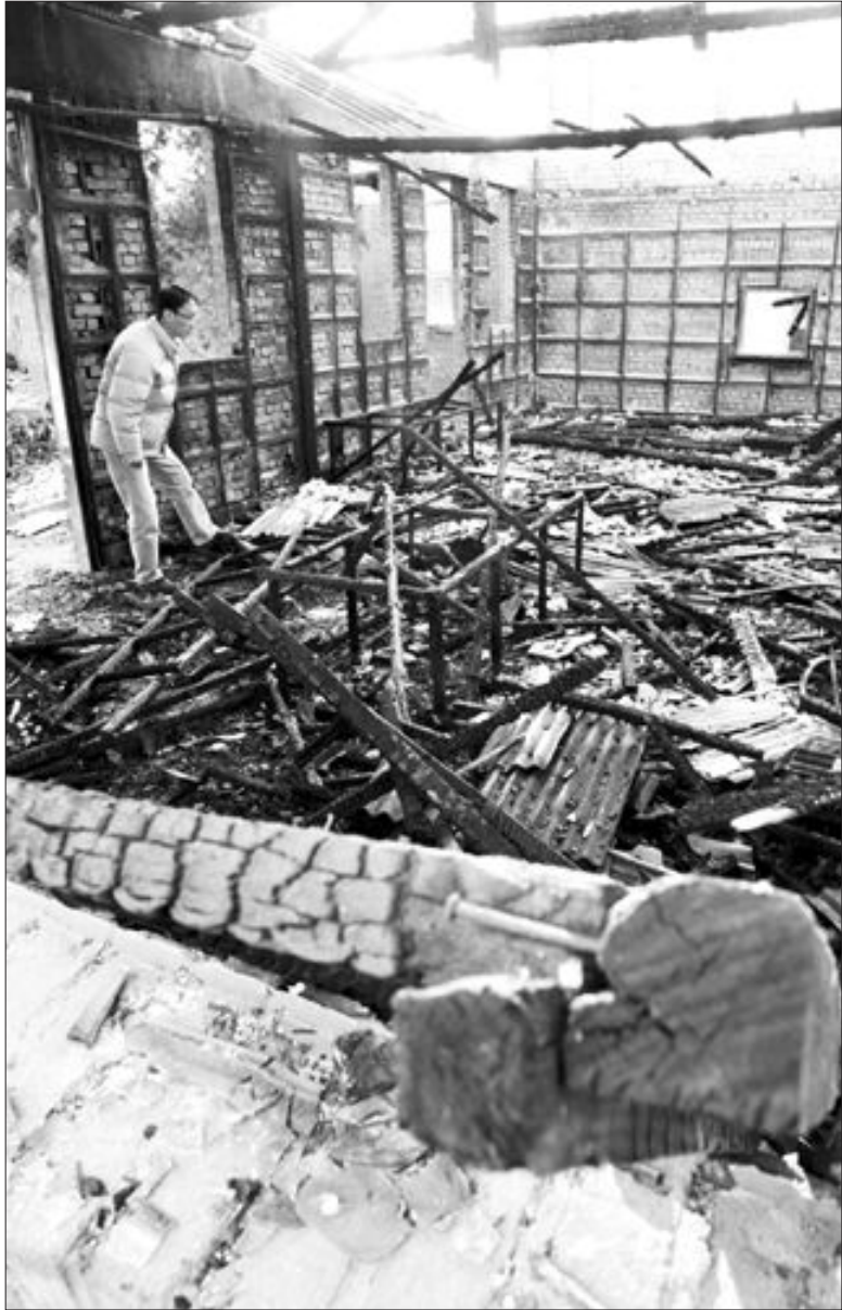
대표적인 5·18 사적지인 옛 광주기무부대 내부 건물이 불에 타고 파손된 채 5년 넘게 방치되고 있다. 이 건물은 80년 5·18 당시 신군부의 지휘본부가 있었으며, 민주인사와 항쟁 지도부가 감금돼 고문을 받았던 곳이다.
