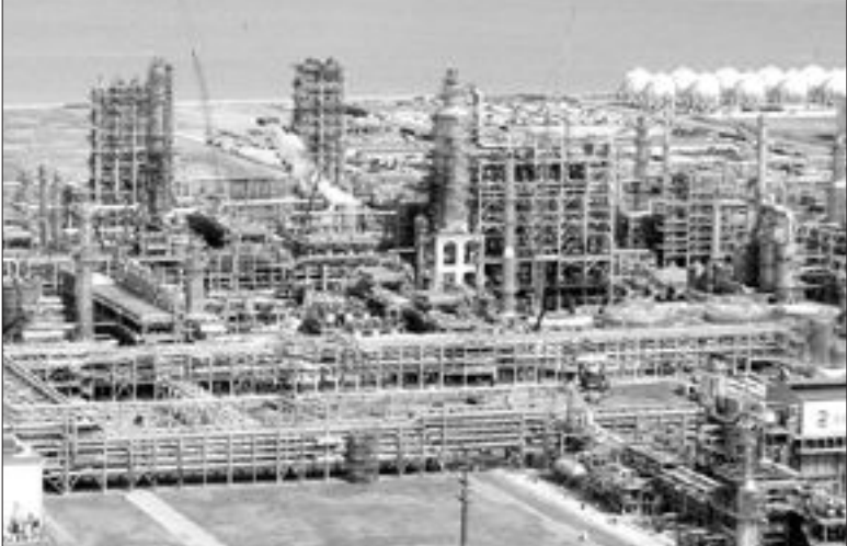
오는 9월 본격 상업생산을 앞둔 GS칼텍스의 세번째 고도화시설인 갑갑산사유 수첨탈황분해시설 전경.
