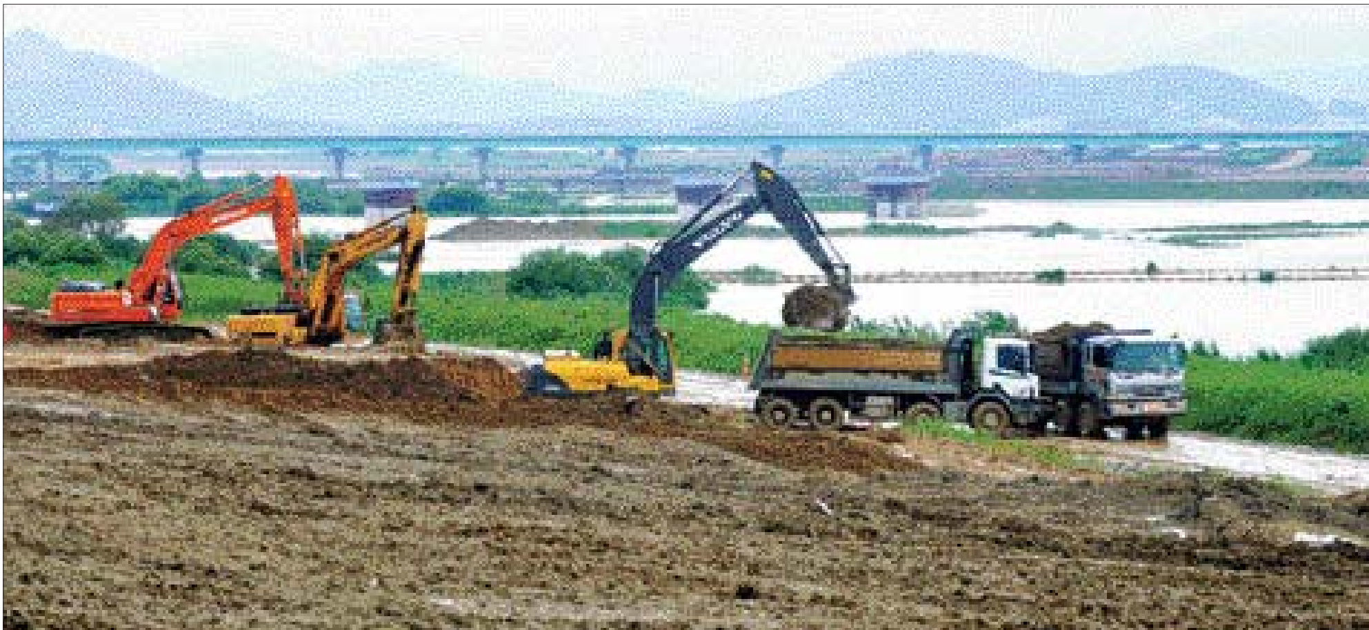
‘영산강살리기 사업’ 승촌보 공사 구간 시공사가 2일 집중호우에 대비해 중장비를 동원, 공사 현장에 쌓아둔 준설토를 다른 지역으로 옮기고 있다.
