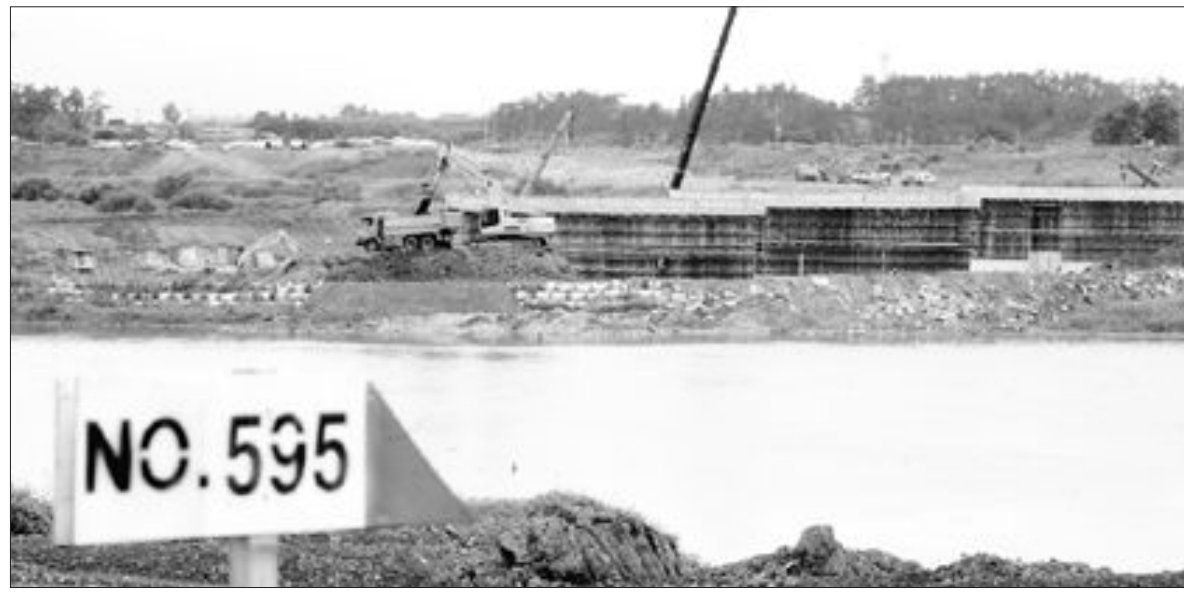
민주당 4대강 사업 지지특별위원회가 8일 현장조사를 위해 방문할 영산강 살리기 사업 내 승촌보 공사 현장. 가물막이를 철거한 뒤 보 설치 작업이 진행중이다. /김진수기자 jeans@kwangju.co.kr
