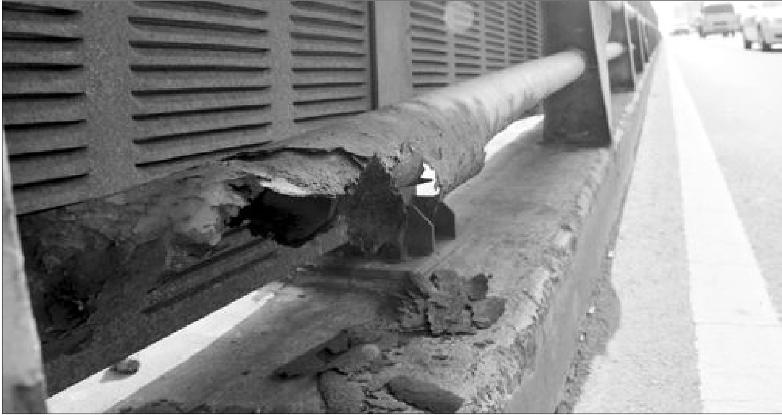
7일 광주시 북구 동운고가 내리막길 지점의 가드레일 하단 파이프가 녹이 슬어 차량의 충돌이나 추락을 막기에는 어려워 보인다. 가드레일 뒤면에 설치된 방음벽은 추락 방지 및 충격 흡수 기능이 전혀 없다. /김진수기자 jeans@kwangju.co.kr
