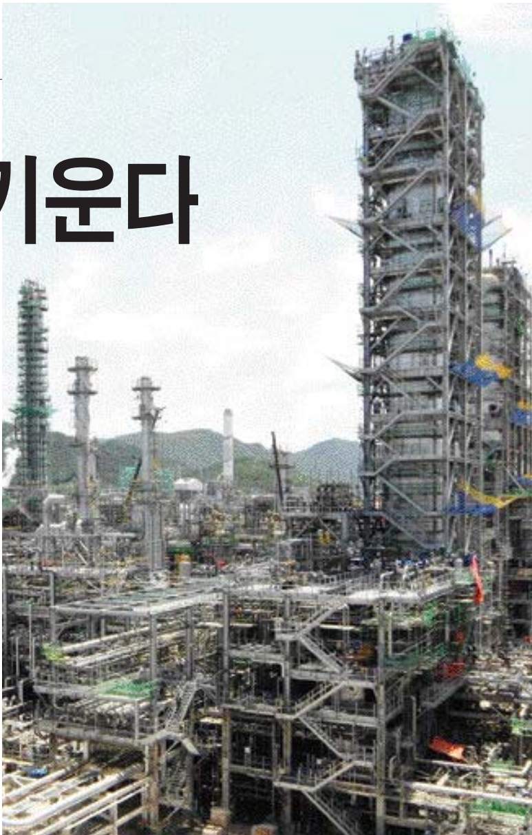
최근 완공돼 시운전에 들어간 GS칼텍스 여수공장의 ‘검압잔사유 수첨탈황보해시설(VHCR·일명 넘버 3)’. 국내 최대 규모의 정유 고도화 설비인 이 시설은 오는 9월부터 본격적인 상업생산에 들어가 연간 6000억 원 이상의 추가 수익이 기대된다.
