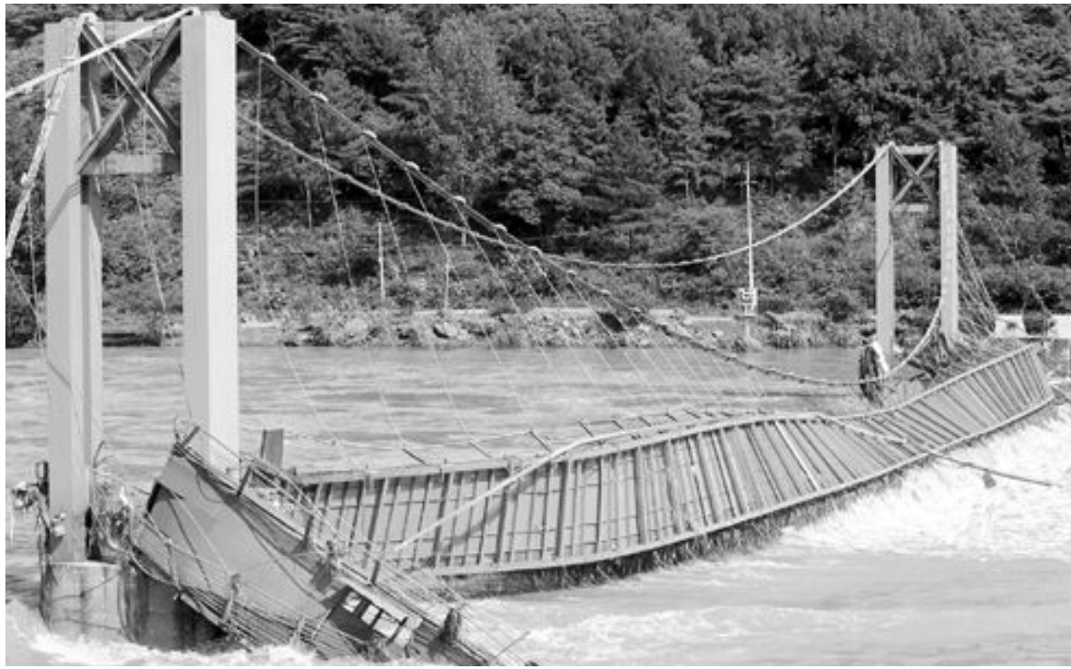
휘어진 다리 185mm의 집중호우가 내린 17일 곡성군 오곡면 가정역에 설치된 길이 168.3m·폭 2.75m의 두가교가 범람한 강물에 심하게 파손되면서 옛가락처럼 휘어져 있다. /최현배기자 choi@kwangju.co.kr
