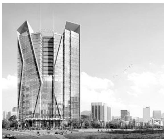
에코그라드호텔의 조감도. 지상 18층 규모로 1,300여명이 참석가능한 초대형 그랜드볼룸 등을 갖춰 대형 연회나 세미나를 비롯한 국제행사를 소화할 수 있다. 최상층의 국빈급 인사가 이용할 수 있도록 최고급룸인 프레지던셜 스위트룸을 갖췄으며 호남 최초의 호텔명품 샵, 최고급 상설뷔페와 3개층을 상류 소셜클럽인 '프리빌리티클럽' 공간으로 꾸밀 예정이다. 순천시 관계자는 “이 호텔이 개관하면 특급호텔 부재로 국제행사나 대형행사 개최가 어려웠던 순천의 지역적 한계를 해결해 줄 것으로 기대된다”고 말했다. /동부취재본부=김은종기자 ejkim@
