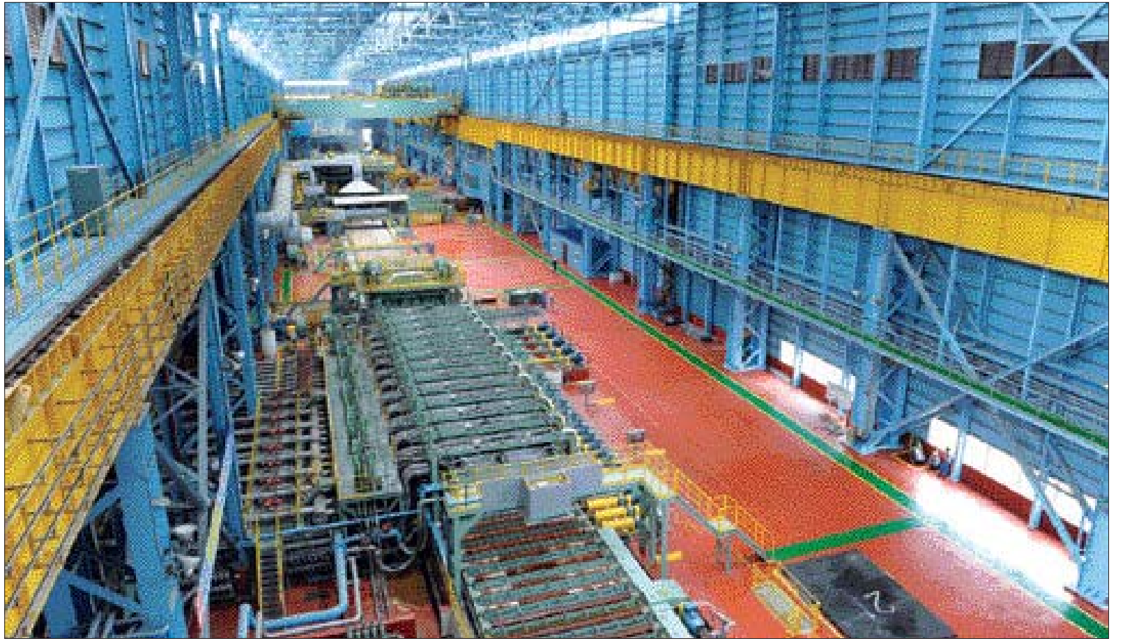
광양제철소 내 38만㎡ 부지에 건립된 광양제철소 후판공장은 제강~연주~압연~출하까지 모든 공정이 자동화 직속시스템으로 운영된다.
