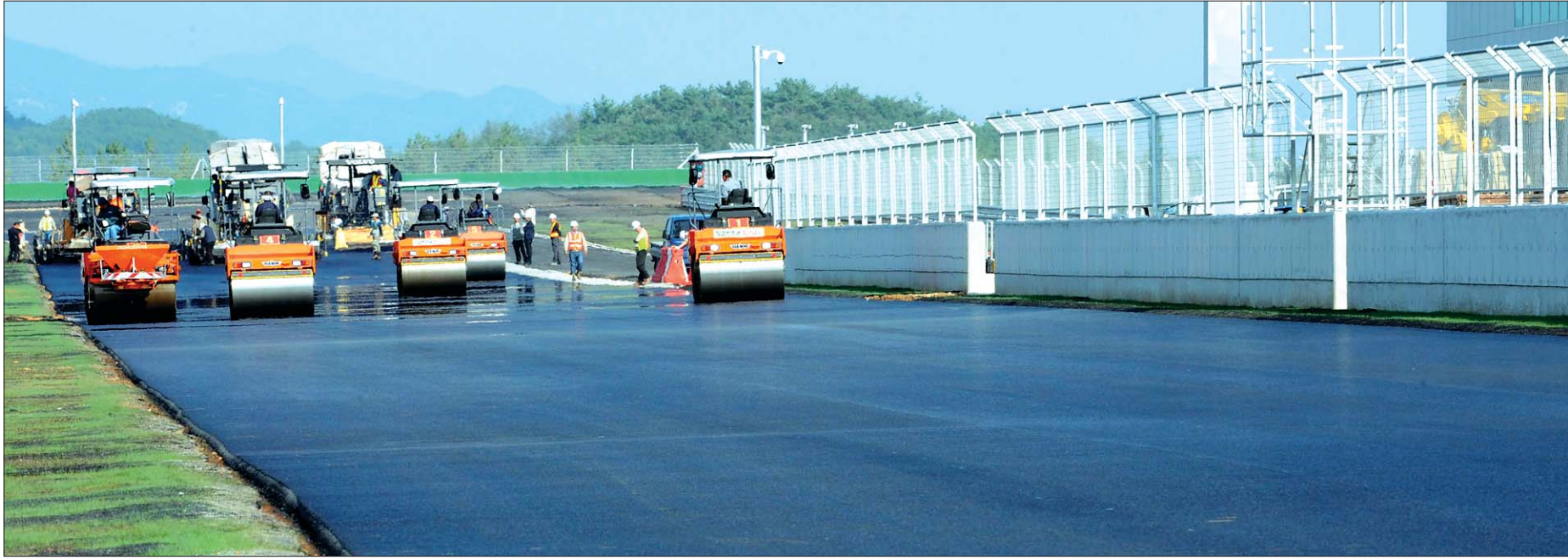
6일 오후 영암 F1 경주장에서 건설 관계자들이 독일 틸케사 전문가들과 함께 서킷 포장에서 가장 중요한 평면도를 유지하기 위해 이스콘 다짐장비인 탠덤(Tandem) 롤러를 이용해 표층포장 다짐 작업을 하고 있다. /영암=나명주기자 mjna@kwangju.co.kr
