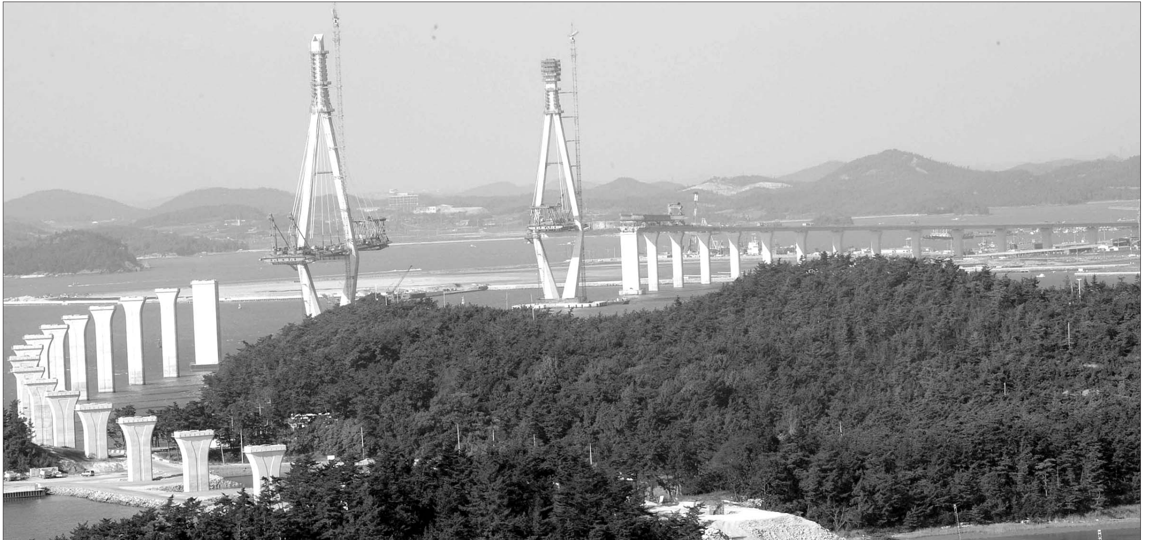
전남도가 추진하는 연륙·연도교 사업의 하나인 목포대교 건설 공사 현장. 전남도는 섬과 섬, 섬과 물을 연결하는 연륙·연도교를 구축, 해양관광산업을 활성화하겠다는 구상이다.
