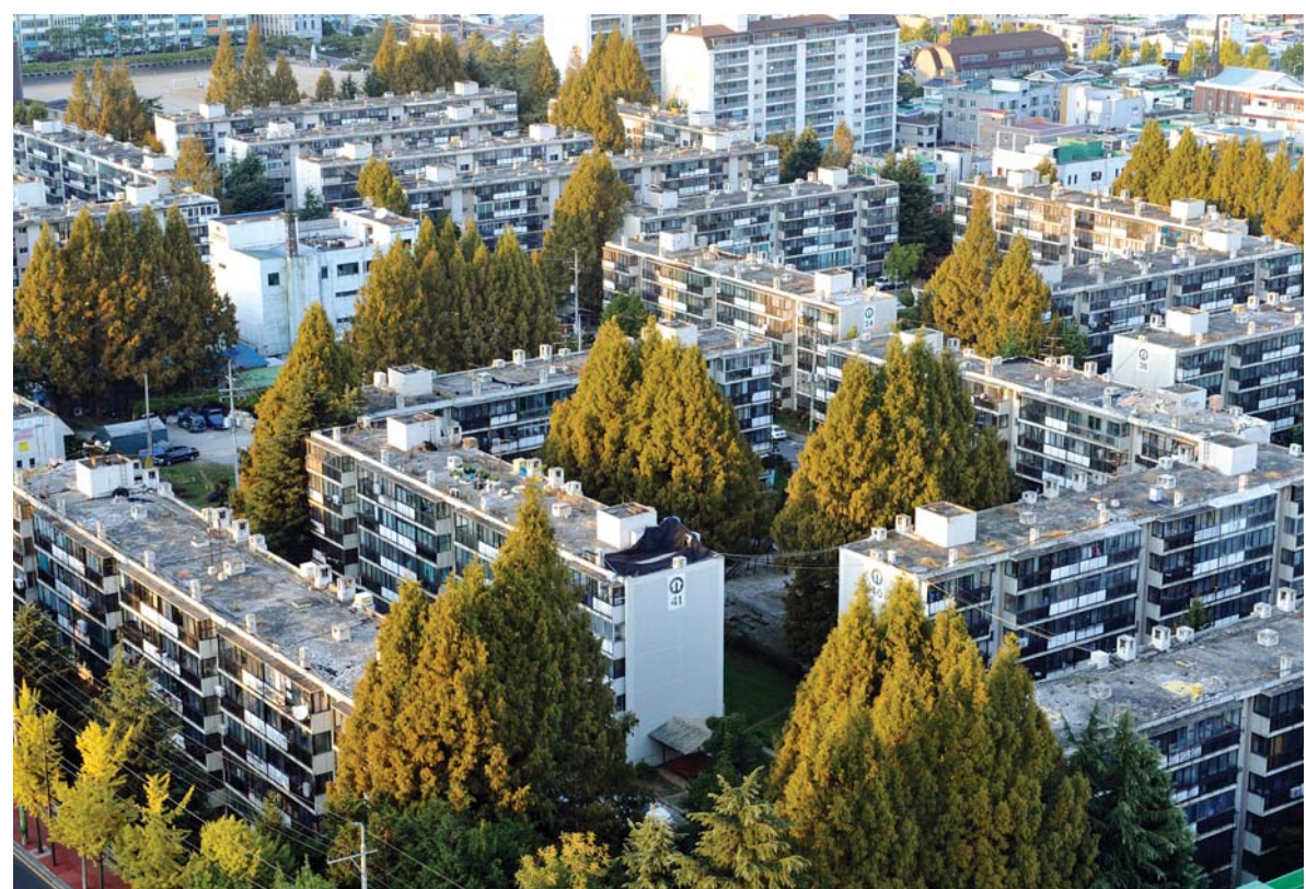
2015 광주유니버시아드대회 선수촌 부지로 확정된 광주시 서구 화정주공아파트 전경. 선수촌 조성에 참여하겠다는 의향을 밝혔던 삼성·대림이 사업참여를 포기하면서 일부 차질이 불가피할 전망이다. 현재 화정주공아파트 내 2900가구 중 92%가 재건축을 통한 선수촌 조성에 동의한 상태다.
