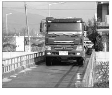
주인 김모(56)씨는 “일반 승용차 2대도 교행이 힘든 다리에 대형 덤프트럭이 들어오면 사람도 지나가기 힘들다”며 “안전진단도 한번 안한 무등록 다리로 언제 붕괴될지 몰라 이용하기가 두렵다”고 말했다.
