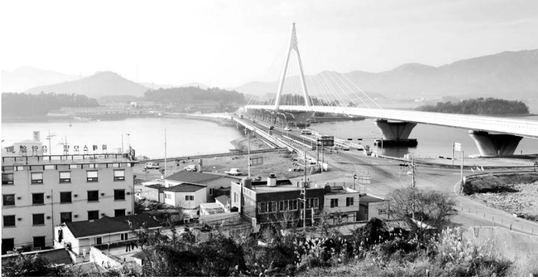
지난 1일 공사가 진행중인 완도군 군외면 원동리 ‘신 완도대교’와 공사로 인해 건물 등에 균열을 입었다는 주장이 제기된 공사현장 인근 상가의 모습(왼쪽).
