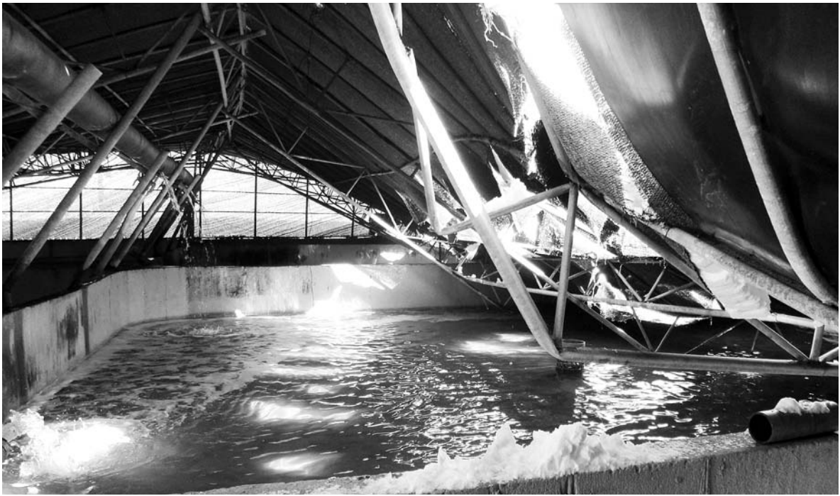
광어양식장도... 전남지역을 강타한 폭설로 수산시설까지 큰 재난을 입었다. 2일 완도 군외면 원동리에 있는 한 광어양식장의 지붕이 쌓인 눈의 하중을 이기지 못해 무너져 내렸다. /서부취재본부=정은조 기자 ejchung@
