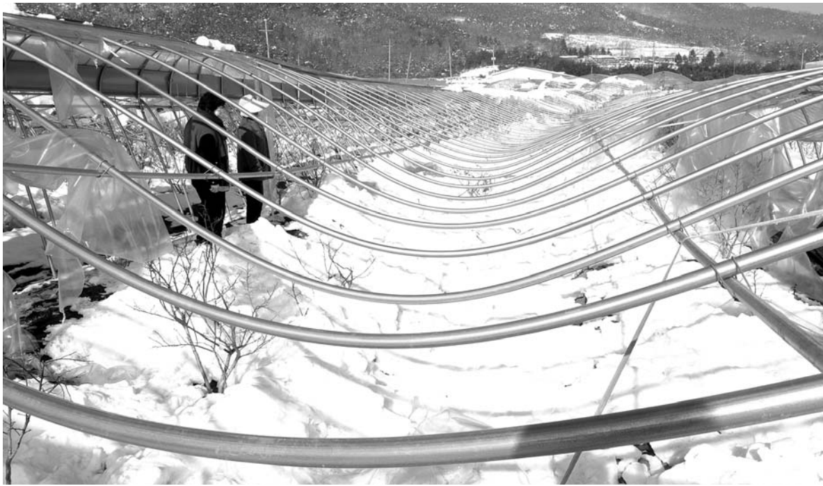
비닐하우스도... 지난 30일부터 2일까지 쏟아진 대설로 각종 시설물이 파손되고 교통사고가 속출하는 등 피해가 잇따랐다. 2일 담양 수북면에서 블루베리 농사를 짓는 이유성(64)씨의 비닐하우스 3동이 눈의 무게를 이기지 못해 지붕 철근이 휘어지면서 주저앉았다. /나명주 기자 namj@kwangju.co.kr
