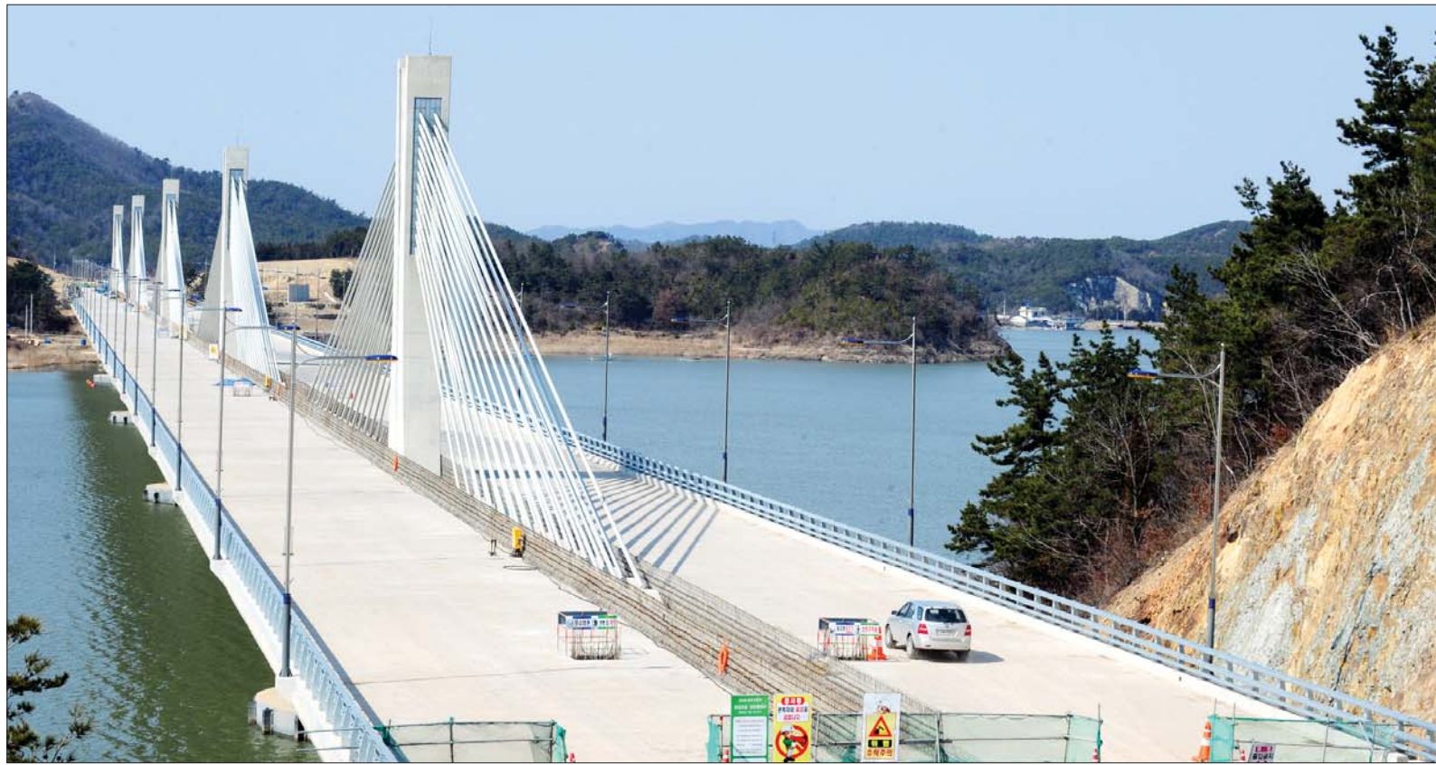
위용 드러낸 무영대교 8일 무안군 일로읍 청호리~영암군 삼호읍 서호리를 잇는 무영대교(길이 860m·폭 26.2m) 건설 현장. 현재 다리 상판이 올라가는 등 85%의 공정률을 보이고 있다. 서해안고속도로에서 목포시내를 통과하지 않고 무안 남악신도시를 거쳐 바로 F1 경주장으로 진입할 수 있도록 설계돼 F1 대회기간 중 수도권과 광주 방면 교통 수요 분산을 위해 추진돼왔다. 익산지방국토관리청은 "대회 이전 개통이 가능하다"고 밝혀 대회 교통난 해소에 청신호가 켜졌다. /최현태기자 choi@kwangju.co.kr
