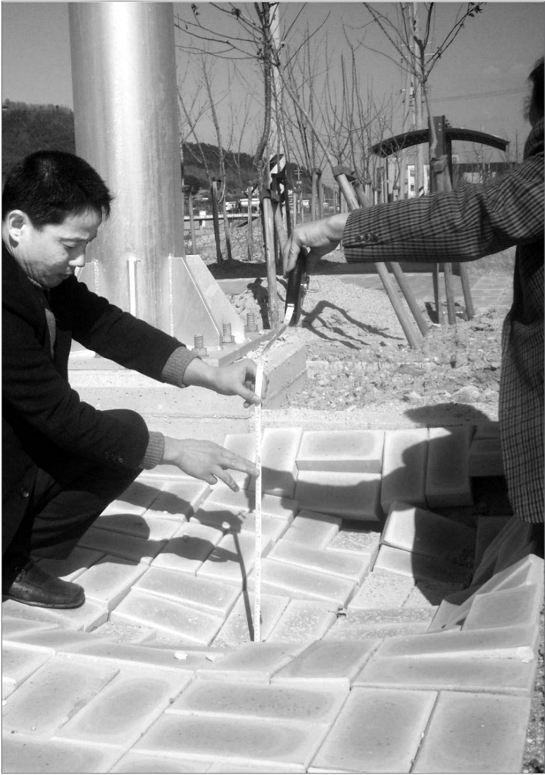
10일 함평읍 기각리 함평천 좌안제 일부 구간 보도블럭을 직접 측정된 결과 30cm가량 침하된 것으로 나타났다. /서부취재본부=황은희기자 hwang@
