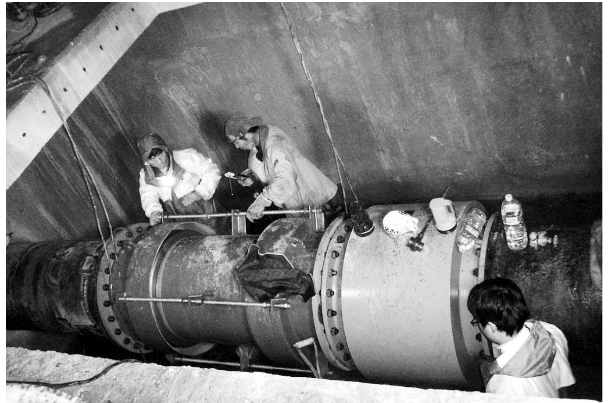
k-water 전남본부, 장성 나노기술산업 상수도공사 k-water 전남지역본부(본부장 이석천)는 최근 장성 나노기술 산업단지내 상수도관 입입 공사를 완료했다. 이번 공사에 따라 나노기술 산업단지 하루 1000여의 물 공급이 가능해졌다. (k-water 제공)
