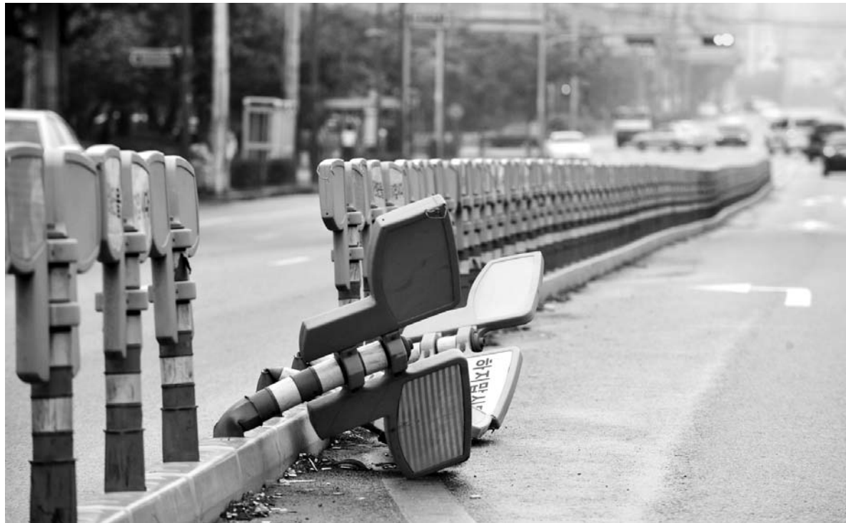
누가 넘어뜨렸을까 조선대학교 치과병원 앞 왕복 8차선 도로 중앙에 설치된 '무단횡단 금지 분리대' 중 일부가 파손된 채 방치돼 있다. /김진수기자 jeans@kwangju.co.kr
