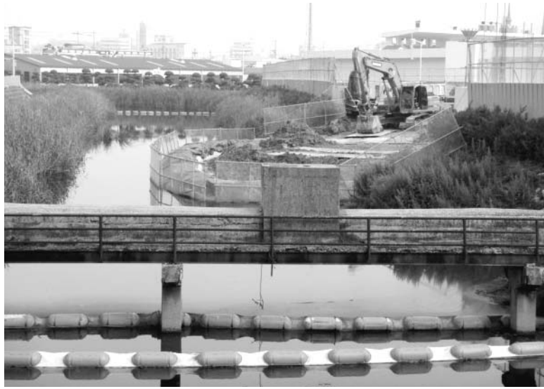
목포시 용당 배수펌프장 토출구가 입암천과 맞닿아 있어 물의 흐름을 방해해 2호광장 침수가 우려된다는 지적이다. 사진은 신설 공사중인 용당 배수펌프장 토출구.
