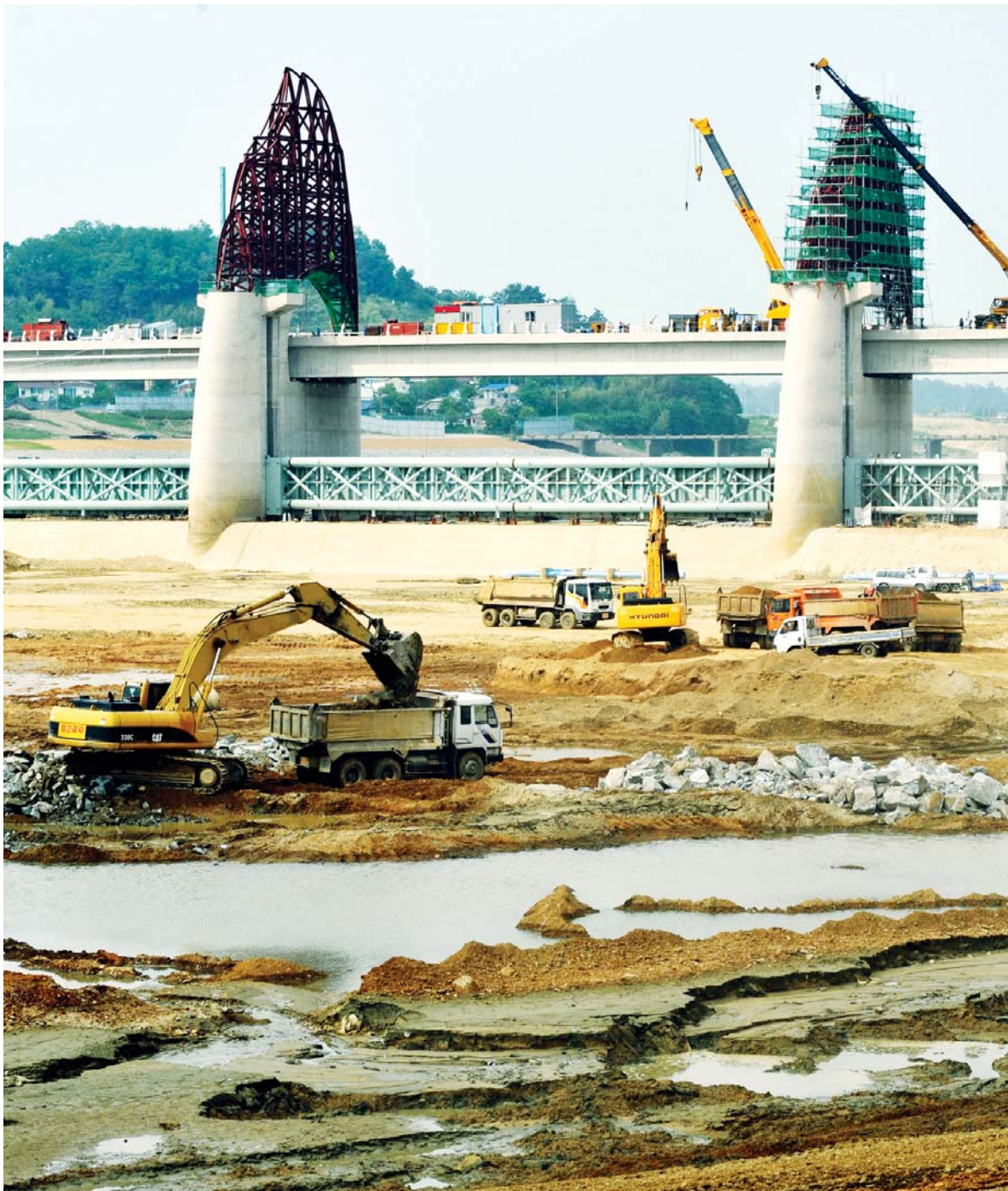
영산강 살리기 사업현장인 광주시 남구 승촌동 승촌보 건설 현장. 완공일이 2주 앞으로 다가 오면서 보 아래에 설치했던 가물막이를 제거하는 작업이 한창이다. /김진수기자 jeans@kwangju.co.kr
