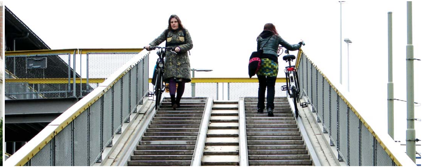
네덜란드 덴 하그의 2층 자전거주차장. 자세히 보면 자전거를 가지고 오르내리기 편하게 계단 옆에 자전거길이 설치돼 있다.
