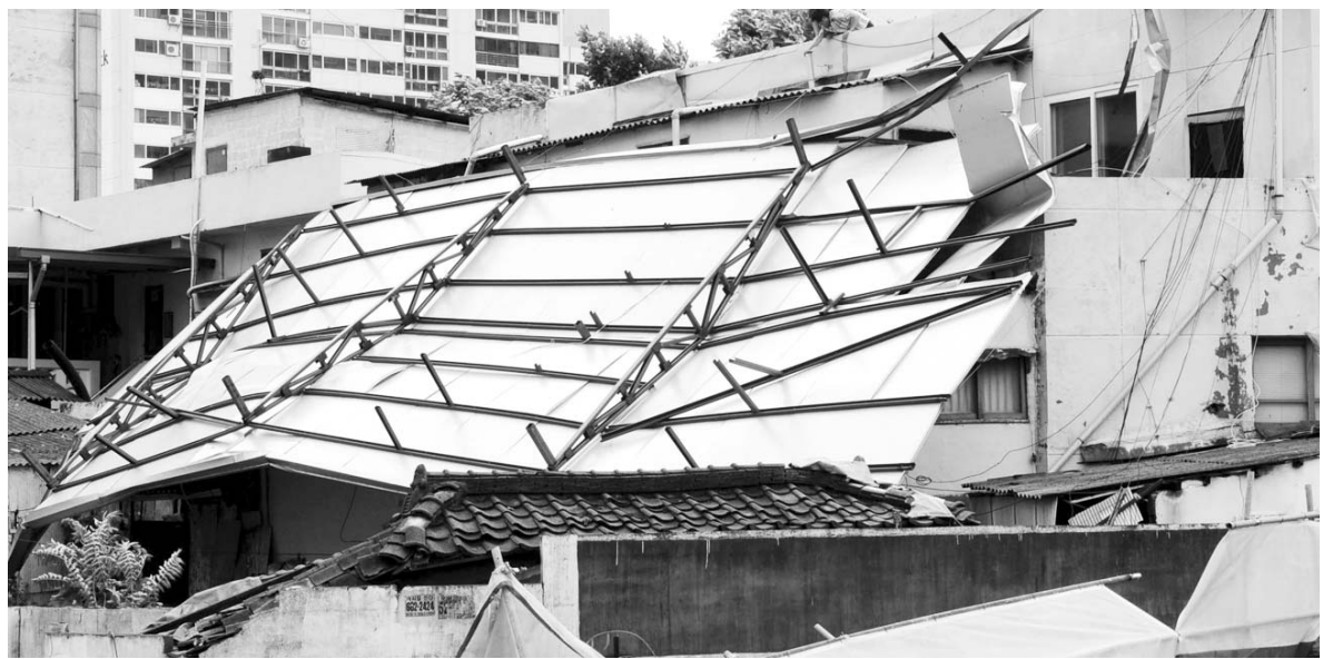
태풍 '메아리'가 몰고 온 강풍으로 26일 새벽 광주시 동구 학동 한 건물 옥상의 철구조물이 무너져내리면서 인근 주택을 덮쳤다. /나명주기자 mjna@kwangju.co.kr
