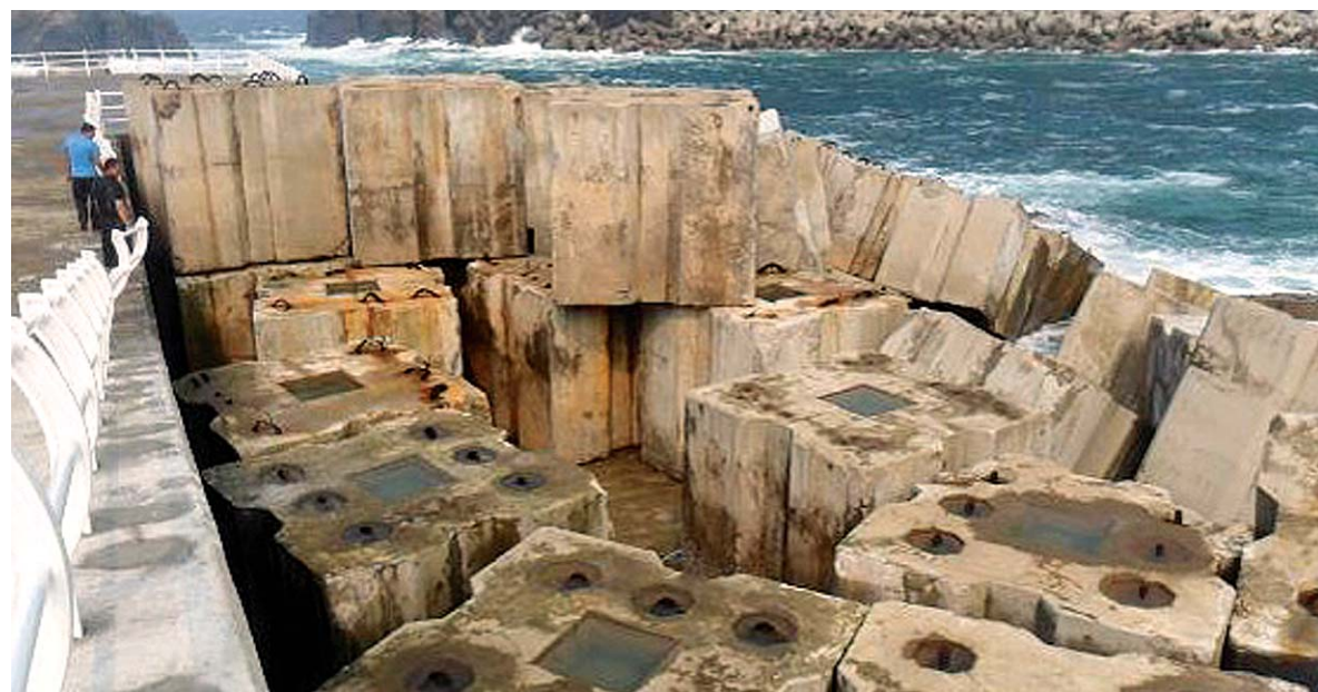
제5호 태풍 메아리가 활귀고 간 신안군 흑산면 가거도 방파제 모습. 방파제 시설인 큐블릭 300개가 유실되고 100개가 파손돼 19억5000여만원의 재산피해가 발생했다. /연합뉴스
