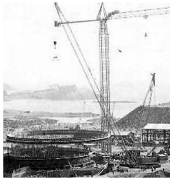
25일로 상업운전 25년을 맞는 영광원전 1호기 건설 당시 모습.
