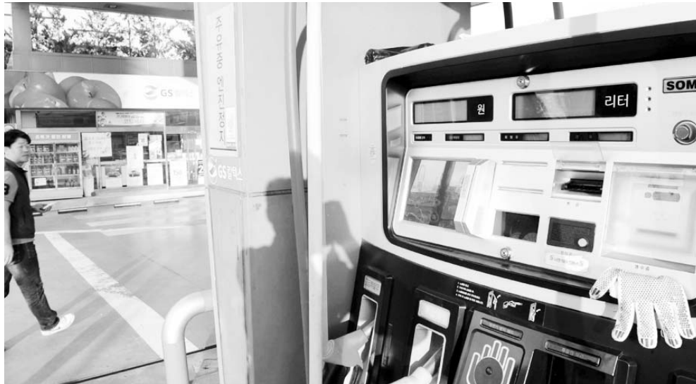
전원 끊겨 계기판이 먹통이 돼 멈춰선 남구 주월동 한 주유소의 주유기.
