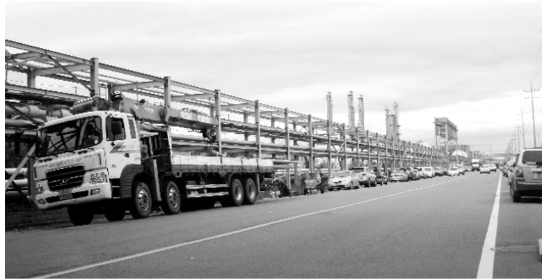
호남석화학 여수공장이 신규 공장으로 연결되는 지상 원료이송관로 철 구조물(구조물 상단부분)을 1km 가량 허가를 받지 않고 설치하다 여수시로 부터 원상 회복 명령을 받았다.
