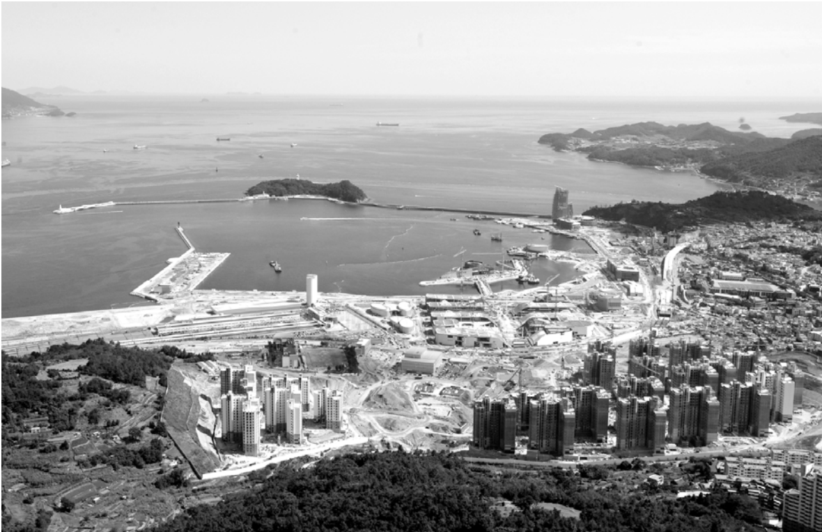
‘2012 여수세계박람회’가 열리는 여수신항 일대 박람회장 건설현장 전경. 박람회 주제를 함축적으로 구현하는 핵심 영구 시설인 주제관(지상 2층·연면적 7413㎡)이 윤곽을 드러내는 등 수심여대의 타워 크레인과 대형 덤프트럭, 굴삭기, 지게차 등이 분주히 움직이고 있다.
