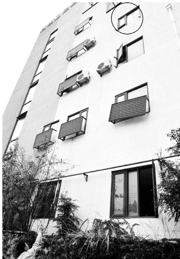
경찰의 불법 도박 단속을 피하려다 베트남인 2명이 추락해 숨지고 1명이 중상을 입은 광주시 광산구 우산동 모델, 사고 현장인 4층 객실 건물 외벽에는 가로 50cm·세로 120cm의 철제 가림막이 보이지 않는다. 원인은 철제가림막이 떨어진 객실 외벽. /김진수기자 jeans@kwangju.co.kr
