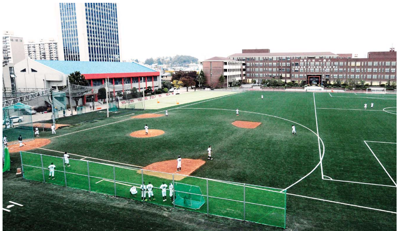
10억1200만원의 사업비를 투입해 조성된 광주일고 인조잔디운동장 전경.
