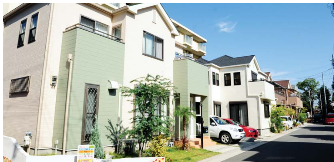
마노지구 골목길과 3층 규모의 공동주택 전경.
