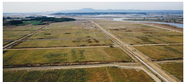
구역만 가능하던 급수가 86ha 전체 사업구역 일괄 급수가 가능해져 영농기간마다 물 부족에 시달리던 농가의 고통도 함께 해결될 예정이다. 광주시는 구역내 영농 편의시설로 전체 용·배수로를 콘크리트 구조물로 시공했으며, 농로도 콘크리트 포장했다.
