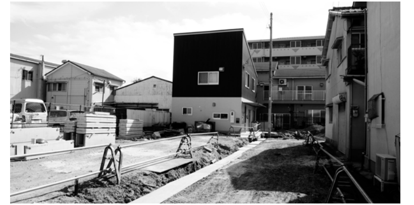
마노지구 마치즈쿠리추진회 사무실 앞. 도로 확장 공사가 한창이다.
