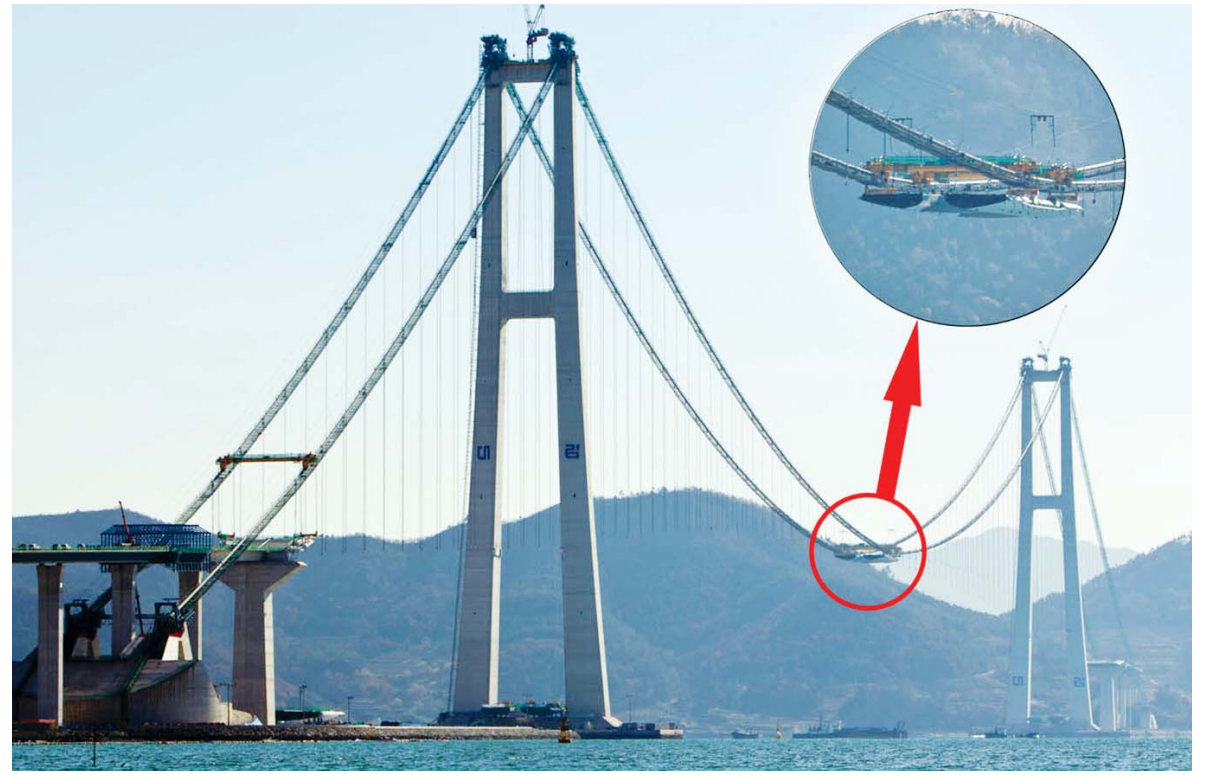
광양~여수 잇는 이순신대교 첫 교량상판공사 완료 지난 5일 광양~여수를 잇는 ‘이순신대교’ 첫 교량상판 거치공사가 완료됐다. 내년 ‘이순신대교’가 완공되면 국가산단간 수송거리와 시간단축(60km→10km, 80분→10분)으로 물류비용 절감과 광양만권 경제활성화에 크게 기여할 것으로 기대된다. <광양시 제공>
