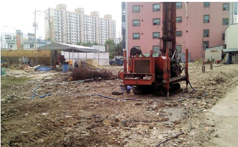
무안군이 발주한 교촌·성남지구 지반침하 보강공사 현장. 명속에 물과 배합한 시멘트 원액(벤토나이트)을 주입해 지반을 굳힌다.
