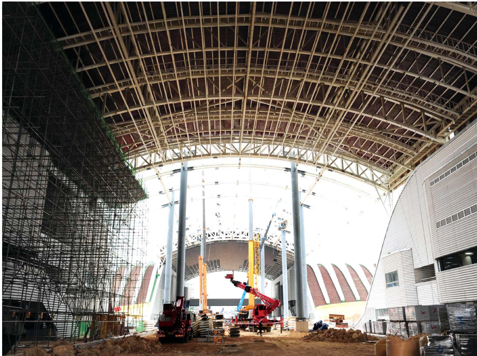
여수세계박람회 100여일 앞 둔 31일, 박람회장과 여수역을 연결하는 아케이드형 '엑스포 디지털갤러리' 건설 공사가 한창 진행되고 있다. 박람회 핵심 전시시설 중 하나인 디지털갤러리는 길이 415m, 폭 21m의 구간 중 218m 천정에 LED전광판을 설치, 불거리를 제공하게 된다. /최한태기자 choi@kwangju.co.kr
