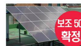
태양광시스템이 적용된 주택의 특징 태양광시스템으로 발전된 전력은 주택전기에 사용되고 남은 전력은 한전으로 역전송 됩니다. 역전송시에 한전계량기를 거꾸로 돌림으로서 전기를 약 80-90% 절약시켜 줍니다. 비가오거나 흐린 날씨에도 태양광은 소수전력이 생산되지만 발전량이 사용량보다 적으면 자동으로 한전 전기가 들어오기 때문에 전기를 사용하는 데는 아무런 하자가 없습니다.
