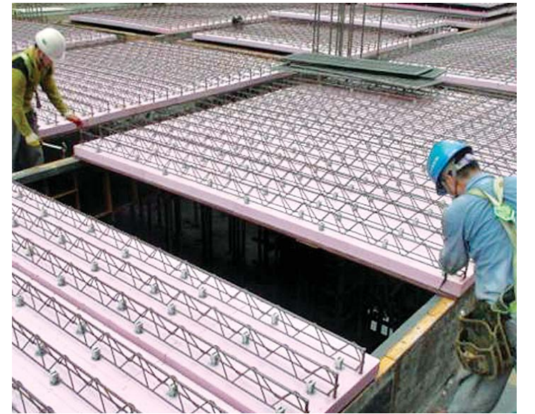
동아에스텍의 신기술 '단열재 일체형 데크 공법'이 건설현장에서 시공 중이다.
