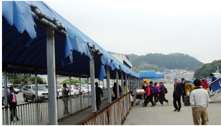
완도항내 선박 승·하선시 이용하는 비막이 시설이 찢겨지고, 철 보호대가 녹슨채 방치돼 보수작업이 시급하다.
