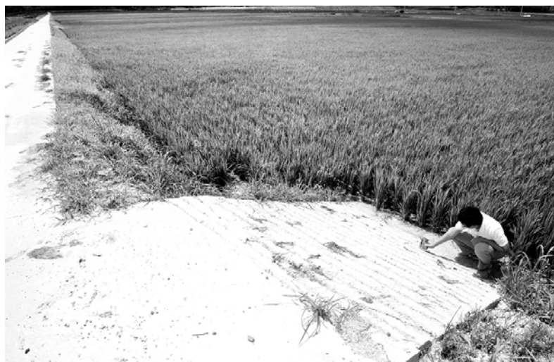
광주시 서구 용두동 농경지 리모델링 지구에 속한 400여 필지의 진·출입로 경사가 25~45도에 이르러 농기계의 출입이 불가능한 상황이다. (왼쪽) 리모델링 공사 중 모래가 사용된 비탈면이 지난 장맛비에 무너져 내리면서 토사가 농지로 유입됐다.
