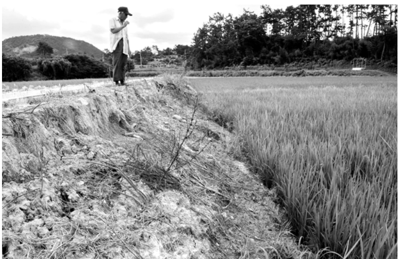
광주시 서구 용두동 농경지 리모델링 지구에 속한 400여 필지의 진·출입로 경사가 25~45도에 이르러 농기계의 출입이 불가능한 상황이다. (오른쪽) 리모델링 공사 중 모래가 사용된 비탈면이 지난 장맛비에 무너져 내리면서 토사가 농지로 유입됐다.
