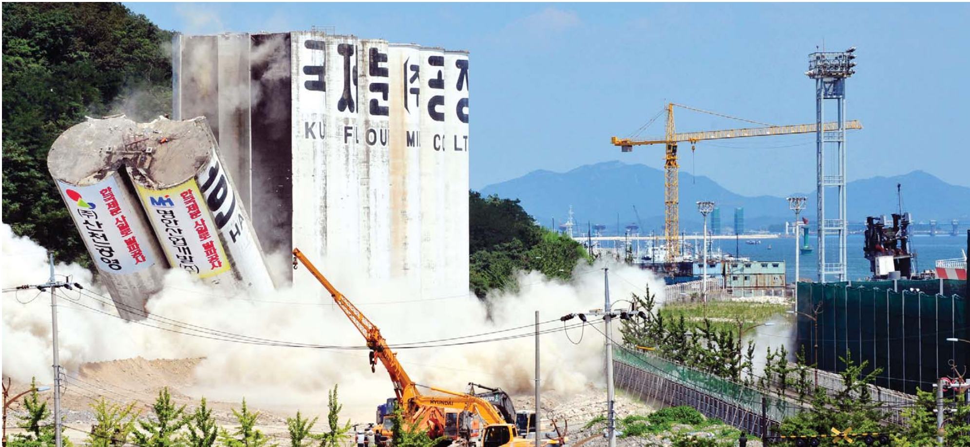
삼학도 사일로 발파 철거 1956년 들어선 목포 삼학도 내 한국제분 목포공장 철거작업이 1일 오후 사일로(가축사료 저장 창고) 14기 가운데 2기를 발파하면서 본격화했다. 나머지 12기는 오는 10일 발파가 재개되며, 이 부지에는 공원이 조성될 예정이다. /김진수기자 jeans@kwangju.co.kr
