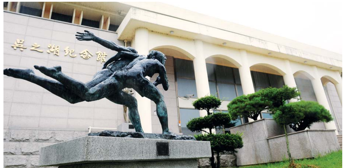
화순군 동북면 오지호 화백 기념관 전경. 기념관만 조성해놓았을 뿐 자치단체의 미흡한 문화 마인드로 지역의 소중한 문화공간으로서 제대로 활용되지 못하고 있다는 지적이 많다.
