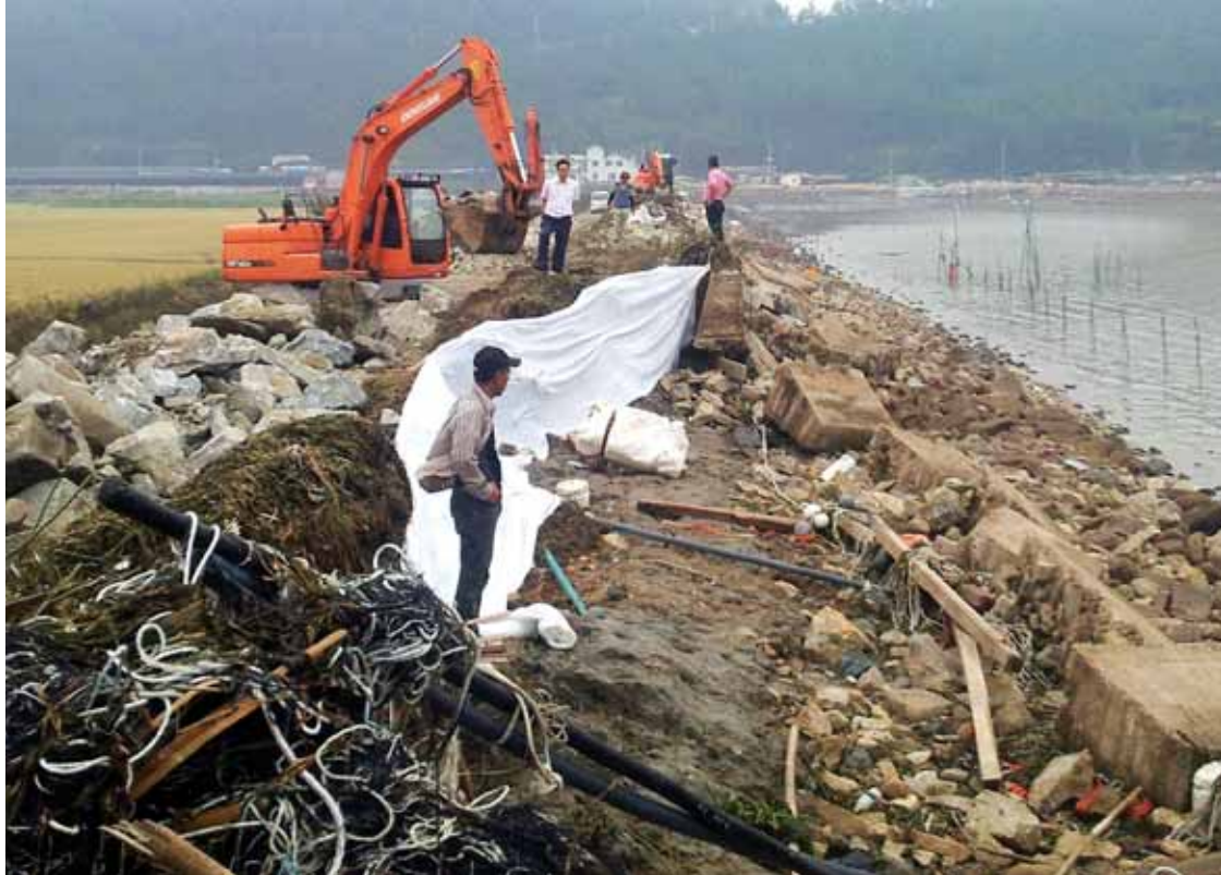
한국농어촌공사 전남지역본부는 지난 29일 강풍을 동반한 태풍 ‘볼라벤’의 영향으로 유실된 강진군 마량방조제에 중장비를 긴급 투입해 23시간만에 복구작업을 완료했다. 마량 방조제는 일제강점기인 1927년에 설치돼 1982년 개·보수했으나 30년이 흐르며 노후화됐다.
