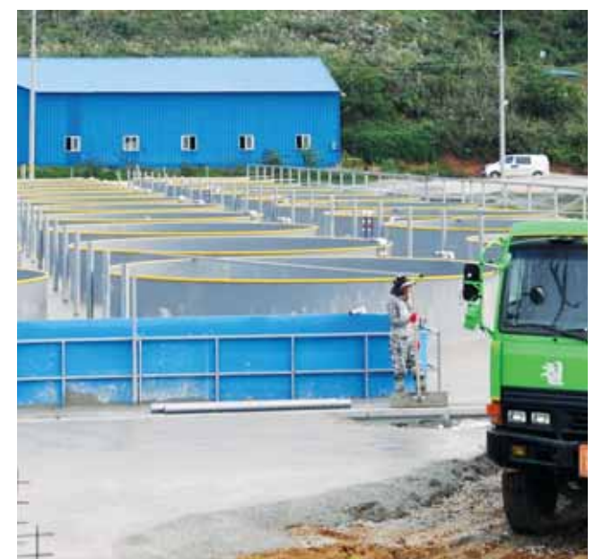
마무리 공사가 한창인 첨단 미꾸라지 양식시설.
