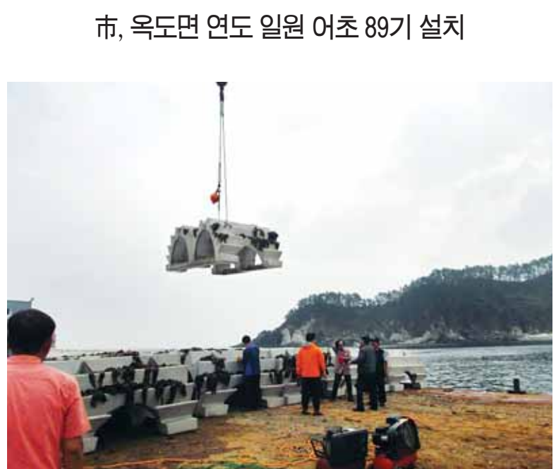
군산 고군산군도 일대에 해양 체험과 수산증식을 위한 '바다 숲'이 조성된다. 군산시는 최근 한국 수산자원관리공단 서해지사와 함께 옥도면 연도 일원에 어초 89기를 설치했다. 바다숲 조성사업은 특수제작된 어초에 전복, 해삼 등 어패류가 좋아하는 갈매, 모자란 등 해초를 직접 이식해 섬 주변 등 연안에 설치하는 사업이다. 시는 다음달에는 고군산군도의 중심인 선유도 해역에도 바다숲을 조성한다. 갈매를 이식한 육각 패널 'H'형 어초를 바다 밑에 설치해 어초체험 관광자원으로 활용할 방침이다. /전북취재본부=박현경기자 dia@
