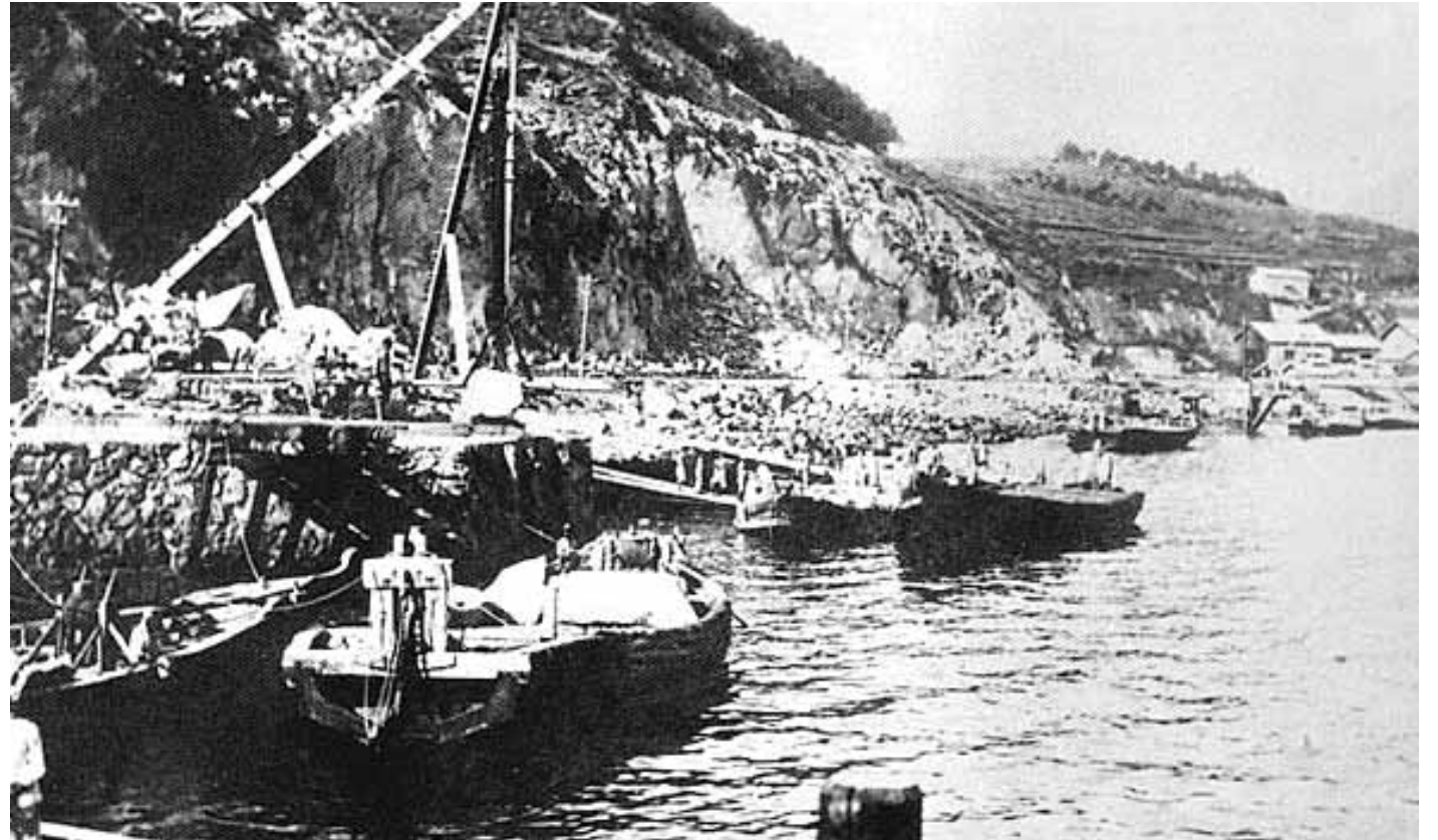
1930년대 여수 오동도 방파제 축조공사
