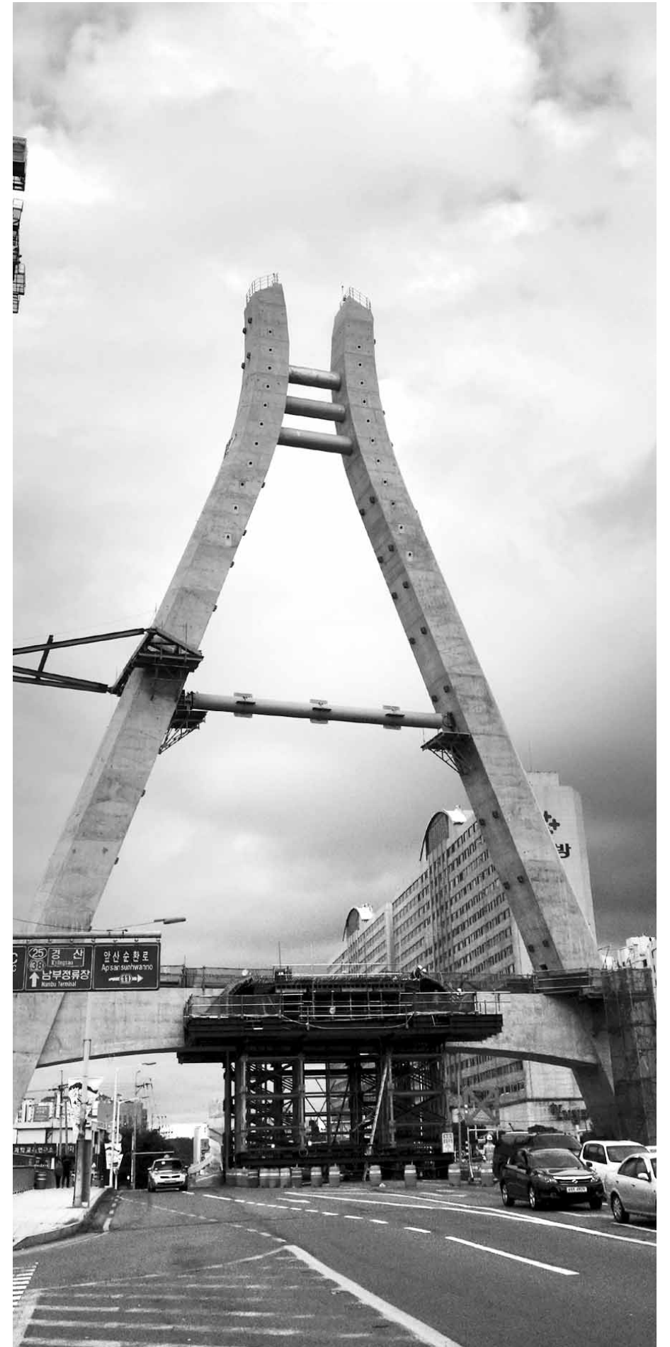
대구시 남구 이천동 대북교 위쪽에 고가 모노레일 방식의 대구도시철도 3호선을 위한 교각이 건설되고 있다. 대구시는 국내 최초 모노레일 경전철이 관광효과를 불러올 것으로 기대 중이다. /사진=김진수기자 jeans@kwangju.co.kr
