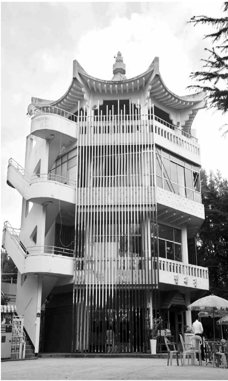
3층 높이 전망타워 설치
