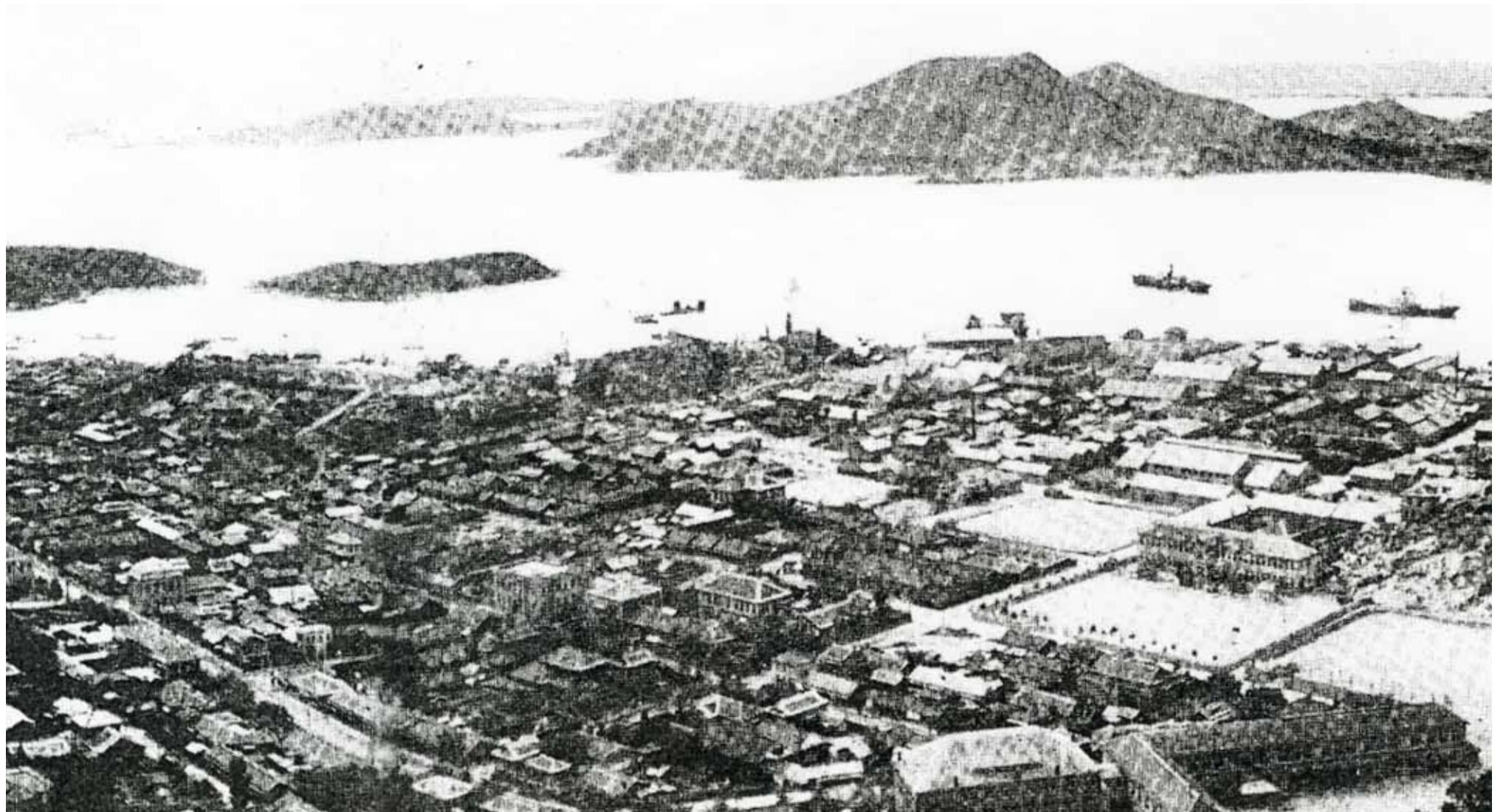
목포항과 각국공동거류지 일부의 전경. 주로 일본인이 거주했던 공동거류지는 격자형 필지로 근대적으로 계획·구상됐으나 여기서 조금 떨어진 한국인 거주지는 부정형하게 난개발됐다.
